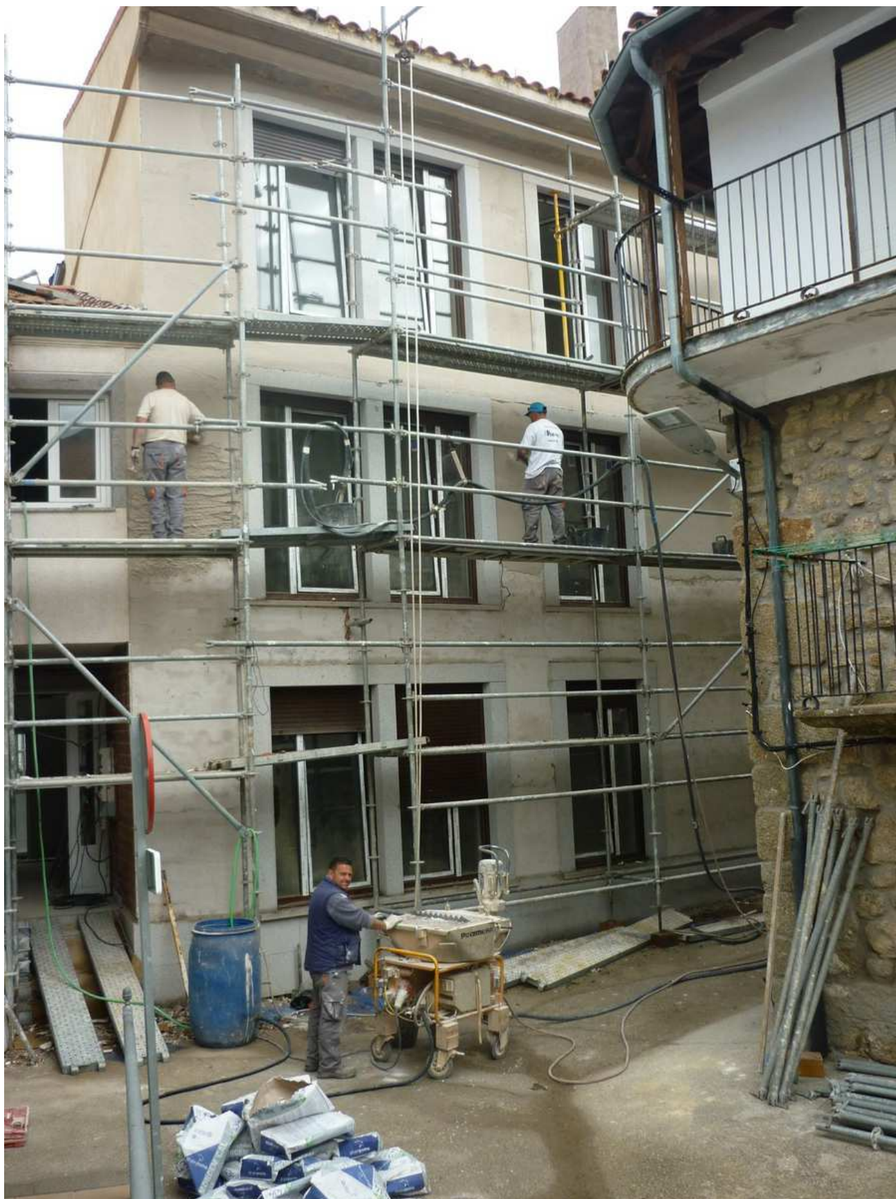
Trabajando en la fachada.
