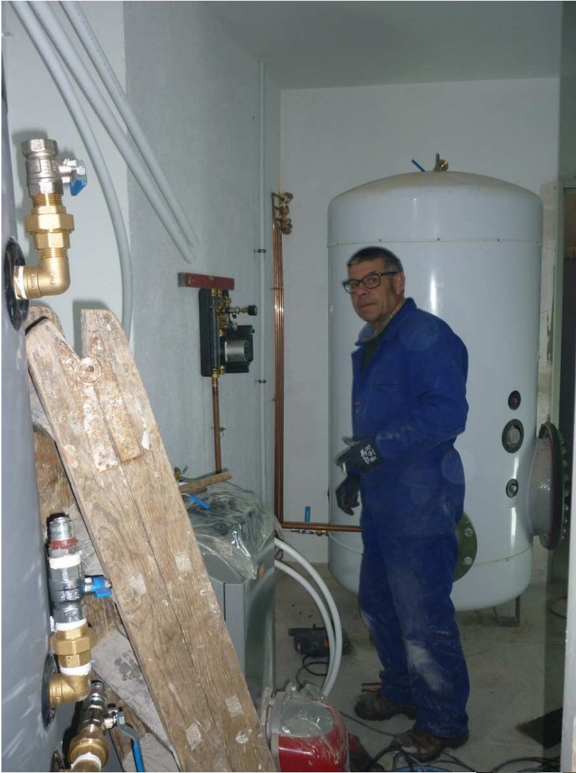
Instalando la calefacción.
