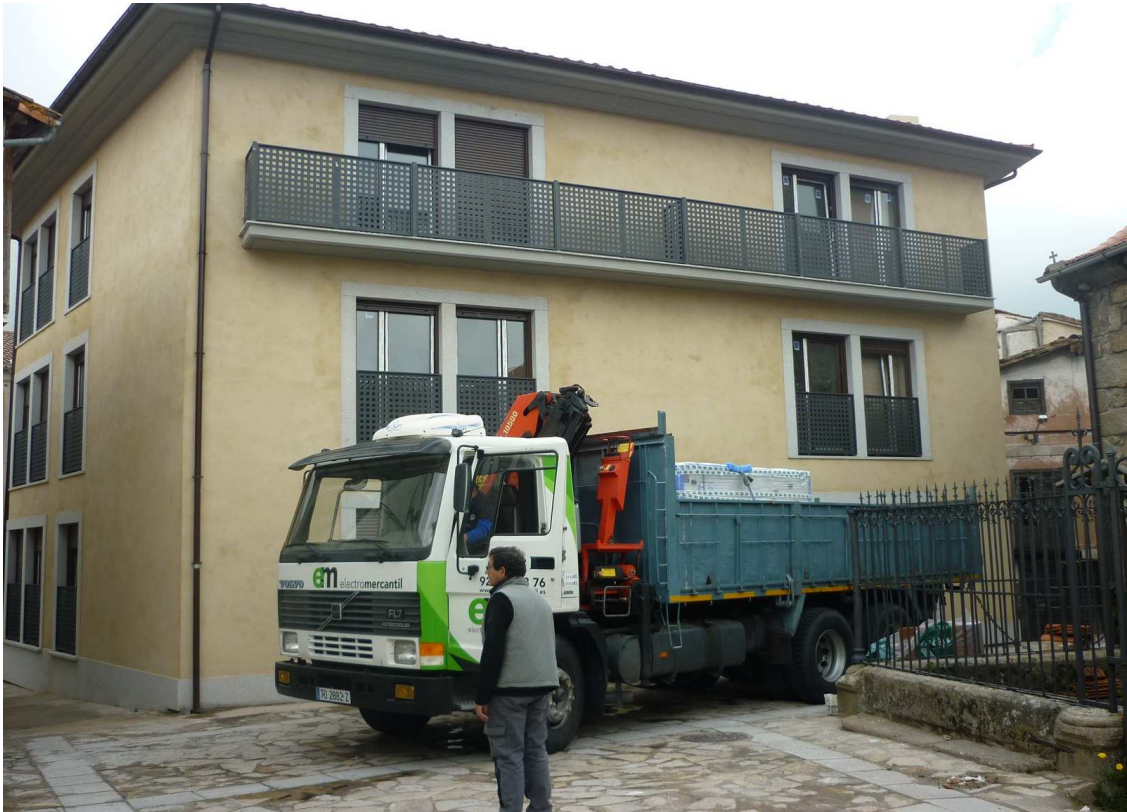
Instalación del grupo electrógeno.
