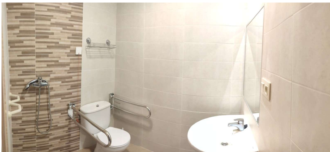
Reforma integral de los cuartos de baño de la residencia antigua.
